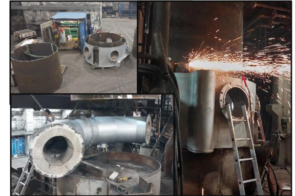
Erneuerung Unterteil Kupolofen (2023)
