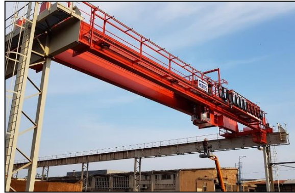
Brückenkran für Gattierung – Tragkraft 8 Tonnen (2019)
